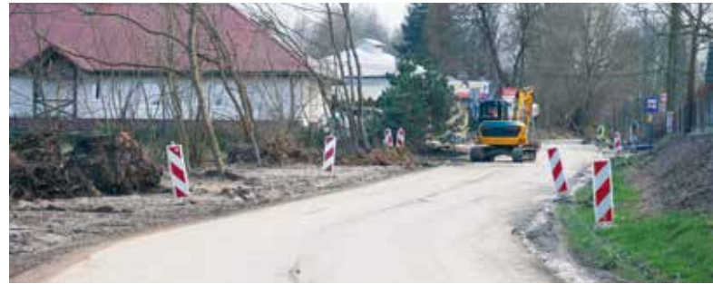
Budowa wodociągu z Krakowa przez Libertów do Lusiny
