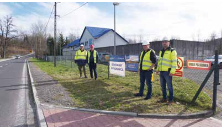
Przekazanie placu budowy przez Wójta na oczyszczalni we Włosani
