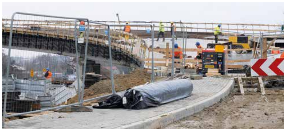
Budowa wiaduktu w Gaju
