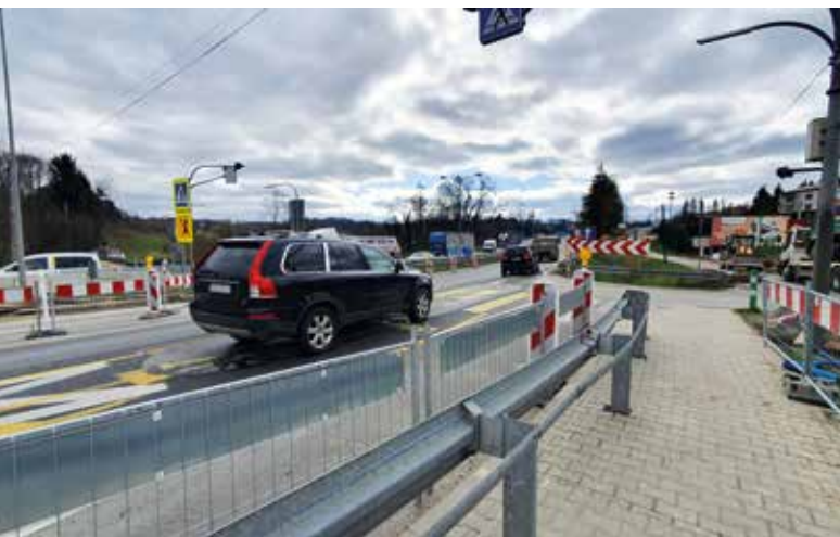
Kładka dla pieszych ul. Żary w Mogilanach
