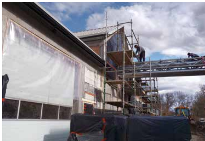
Prace przy oczyszczalni ścieków w Lusinie
